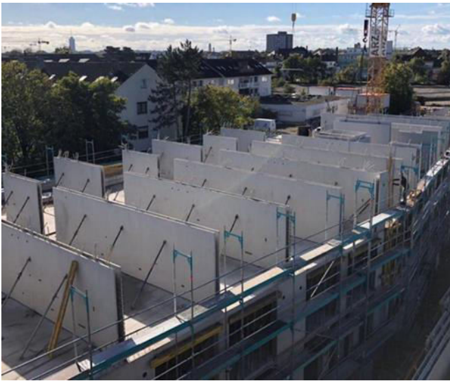
Şekil 1: İçi boşluklu betonarme bölücü duvar
