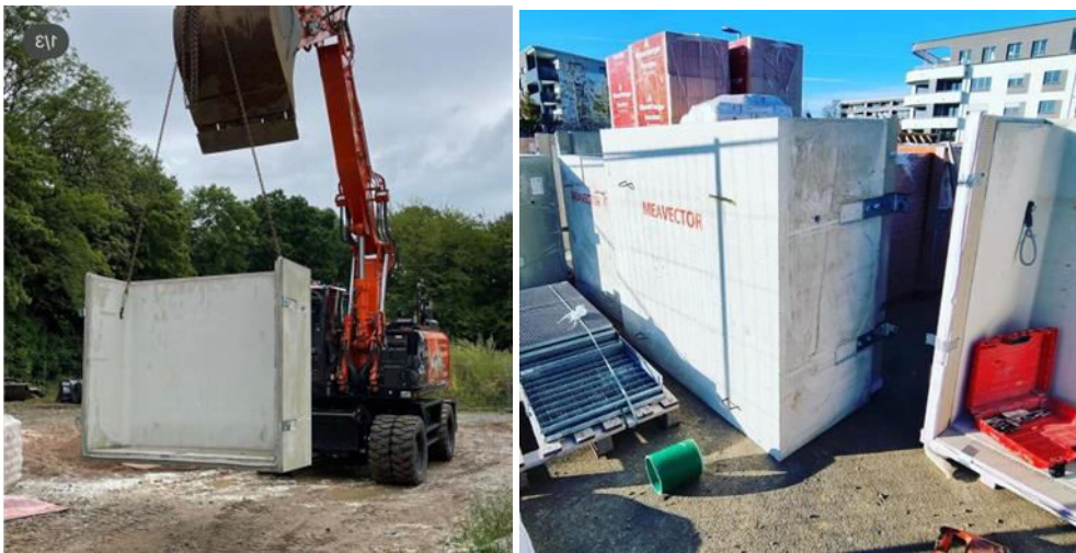
Şekil 10: Prefabrike Üretim Aydınlik Açıklığı
