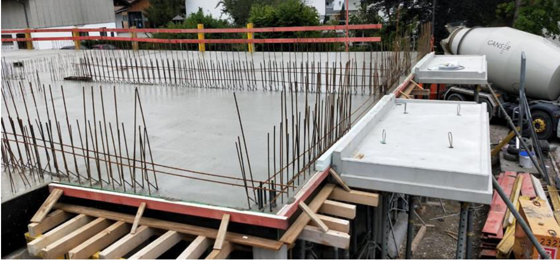
Şekil 9: Hazır Betonarme Balkon Döşemesi
