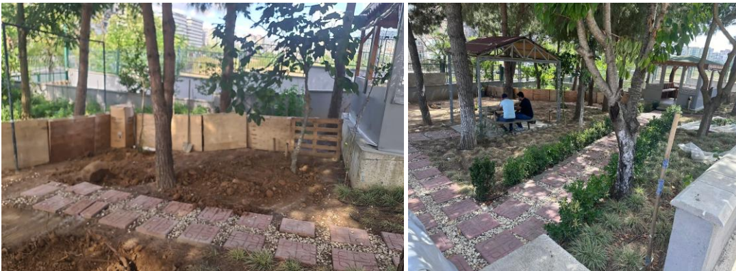
Şekil 5: Yer Altı Sistemin Yüzey Kapalı Görüntüsü
