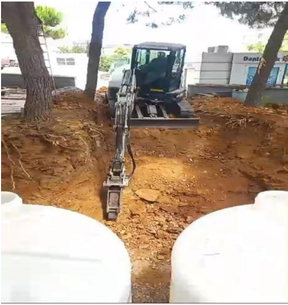
Şekil 4: Yer Altı Yağmur Suyu Toplama Sistemi Alan Hazırlığı
