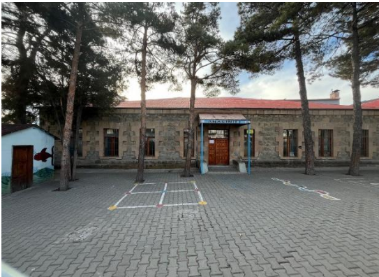
Şekil 2: Yapının Kuzeydoğu Cephesi
