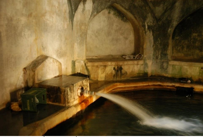
Şekil 3: Eskişehir İli, Sivrihisar İlçesi, Karahisar Hamamı Havuzu.
