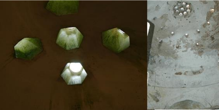
Şekil 4: Eskişehir İli, Han İlçesinde bulunan Hamam yapısının kubbesi ve sağda Sivrihisar İlçesi, Çifte Hamam kubbe aydınlatmaları.
