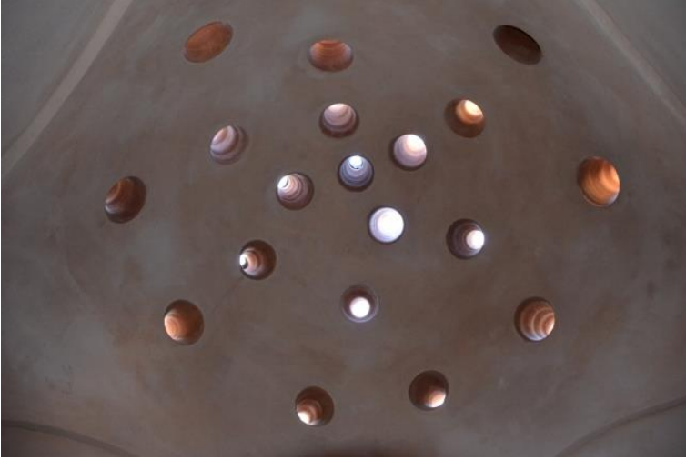
Görsel 2: Aydınlatma Pencereleeri Kaynak: Yazar tarafından üretilmiştir
