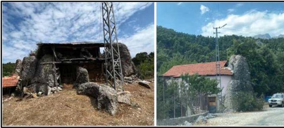
Şekil 6: Ballıbucağ Mahallesi'nde yaygın olarak görülen konglomera sütunlarından yöre halkı mesken, avlu duvarı, ağıl yapımında yararlanmaktadır.
