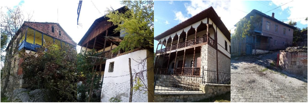
Şekil 5: Cephe Öğeleri (Sırasıyla 72 ada 27 parsel, 83 ada 8 parsel, 86 ada 4 parsel (Kültür Evi) ve 89 ada 1 parselde bulunan yapılar) Kaynak: Arazi çalışması 2022.
