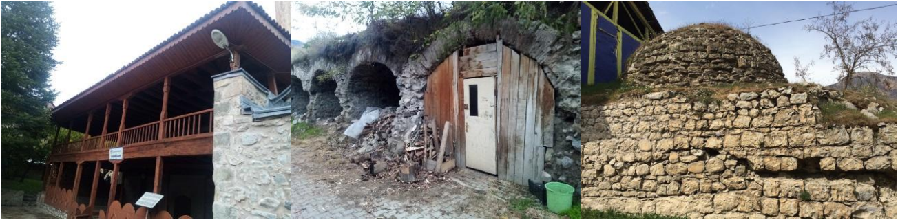
Şekil 3: İskender Paşa Cami, Arasta Dükkânları ve Hamam
