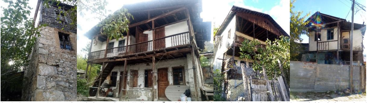
Şekil 6: . Konut Yapım Sistemleri ve Malzeme Kullanımı Örnekleri (Sırasıyla 72 ada 27 parsel, 72 ada 44 parsel, 83 ada 8 parsel ve 72 ada 10 parselde bulunan yapılar)
