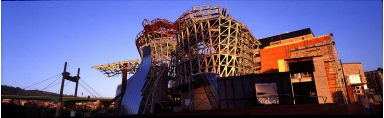
Şekil 7. Guggenheim Bilbao Müzesi'nin Yapım Aşaması (Çelik Strüktür)
