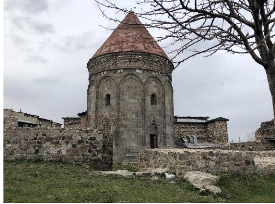
Resim 2. Çifte Minareli Medrese Mevcut Güney Cephe (Kişisel Arşiv, Nisan 2021)
