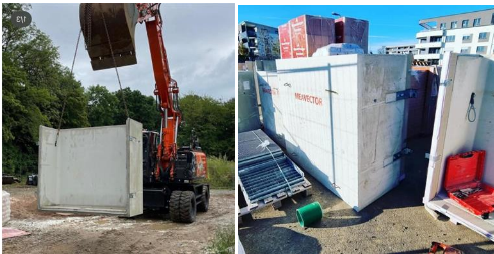
Şekil 10: Prefabrike Üretim Aydınlik Açıklığı
